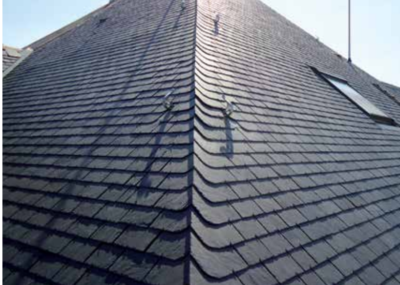
Assulo® Schiefer 35 x 25 cm Rechteckdoppeldeckung mit Klammerhaken gedeckt.
