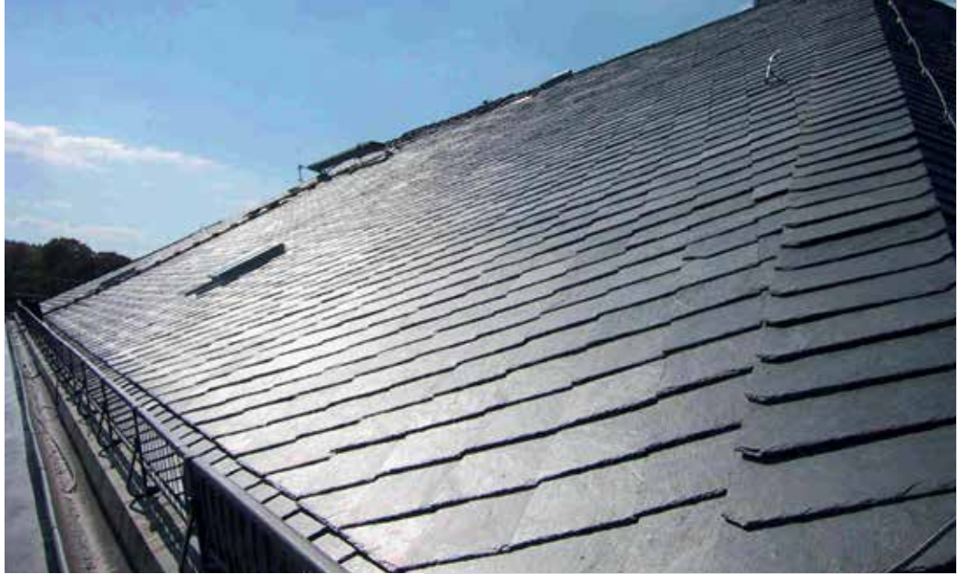
Dachdetail Assulo® Schiefer Spitzwinkel Eco Star 43 x 32 cm. Aufgelegter Ort am Grat
